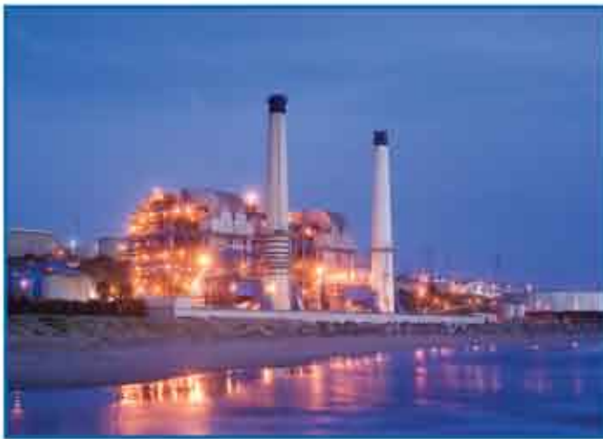
El Segundo Power Plant
